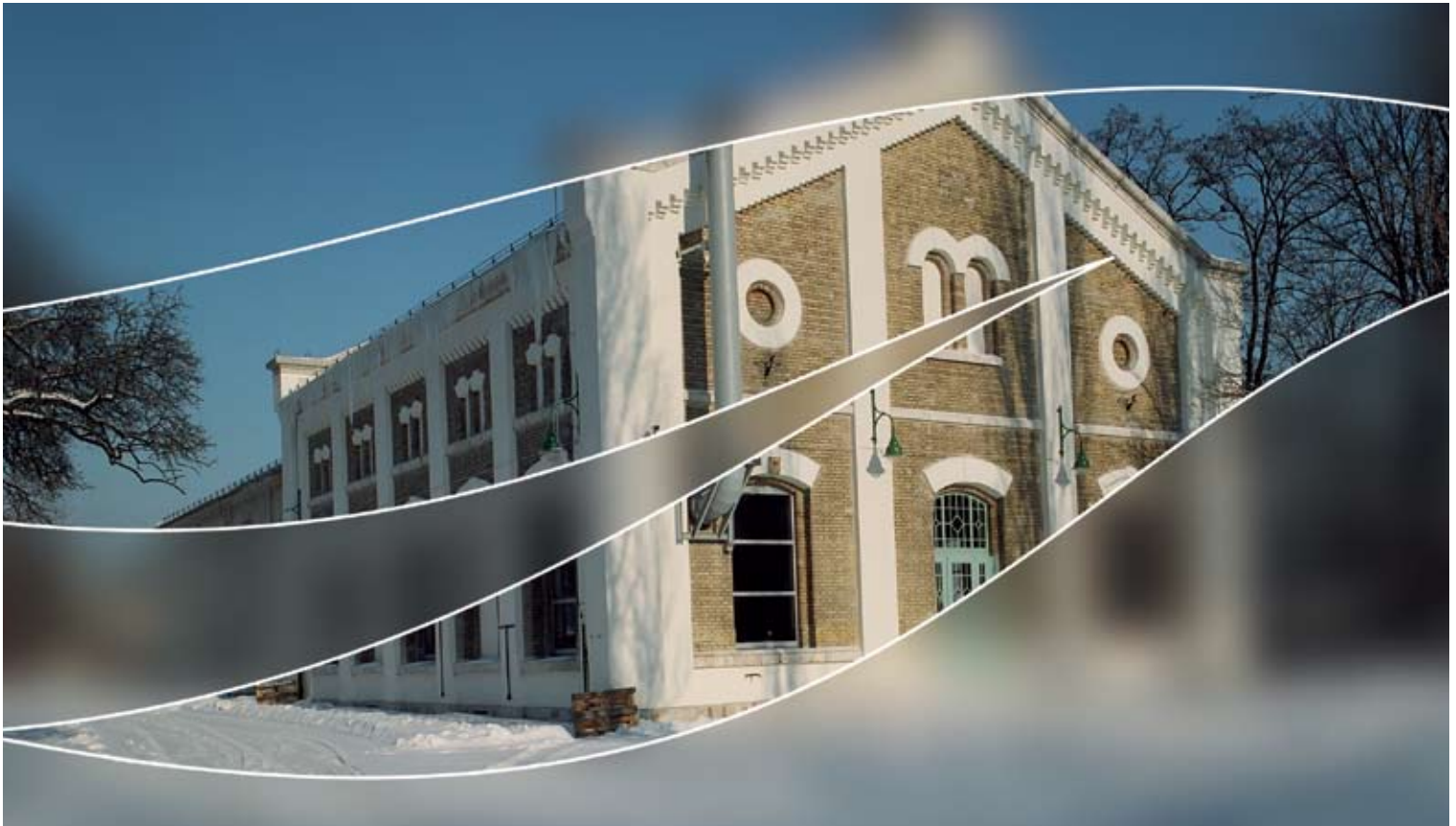
Gépház Pump house
