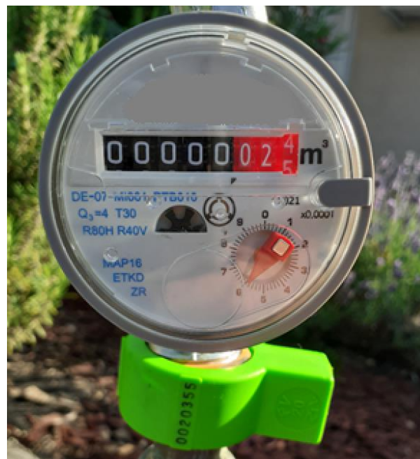
Zöld színű, sorszámozott biztonsági zárógyűrűvel ellátott locsolási célú mellékvízmérő
