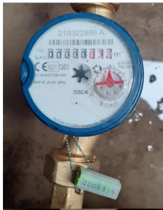
Zöld színű, sorszámozott, függő biztonsági záróelemmel ellátott locsolási célú mellékvízmérő
