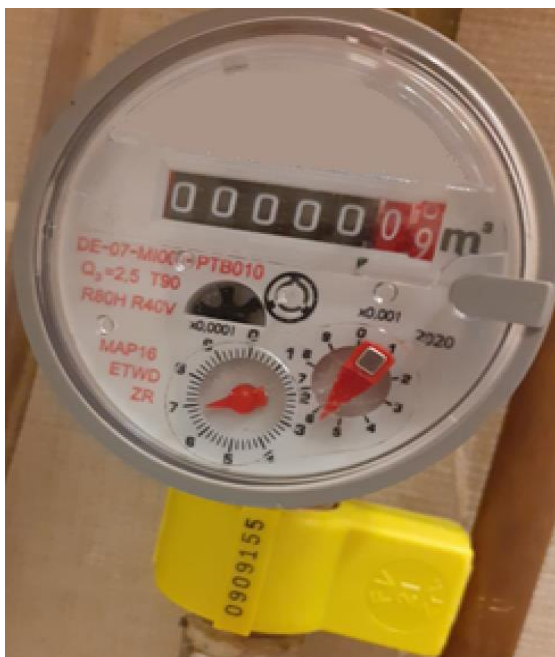
Sárga színű, sorszámozott biztonsági zárógyűrűvel ellátott lakás-mellékvízmérő
